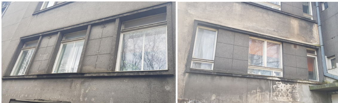
Aknaid rõhtsaks lindiks siduvad vahevööd/ karniisid ja akendevahelised krohvi profileeringud
