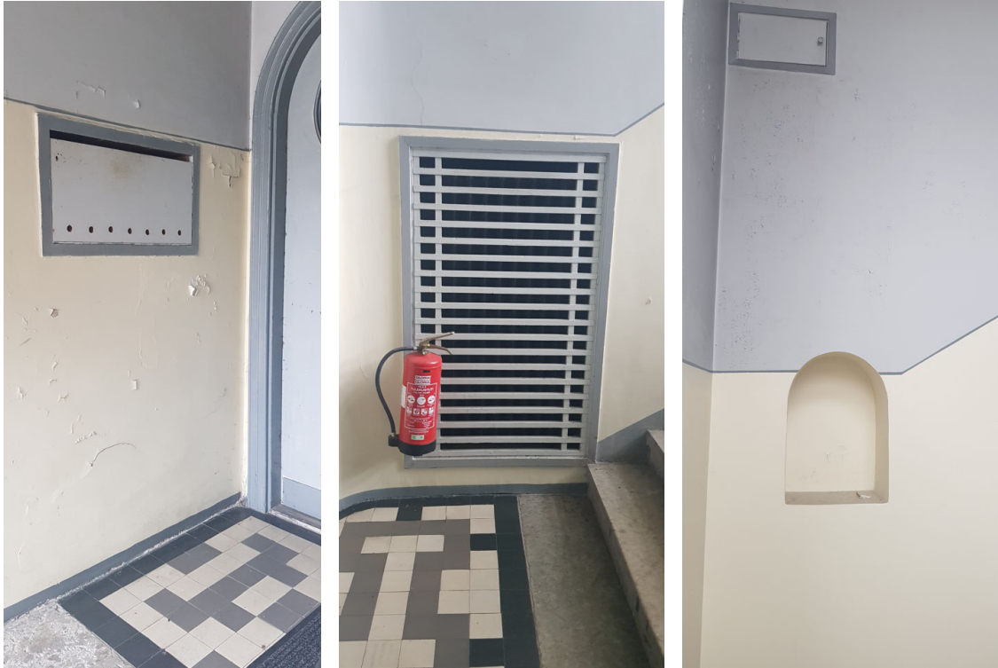
Trepikoja detailid, vasakult postikastide nišš( vahetatud esikilp), radiaatorinišš, seinanišš
