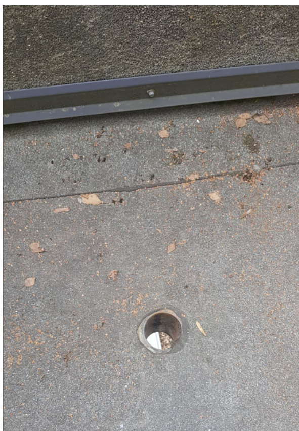
Lõunafassaadi rõdu äravoolud, põrand ja piirde detail
