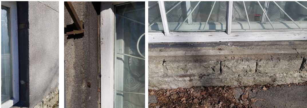
Äripinna vitriinaknad ja soklit kattev betoonplaat
