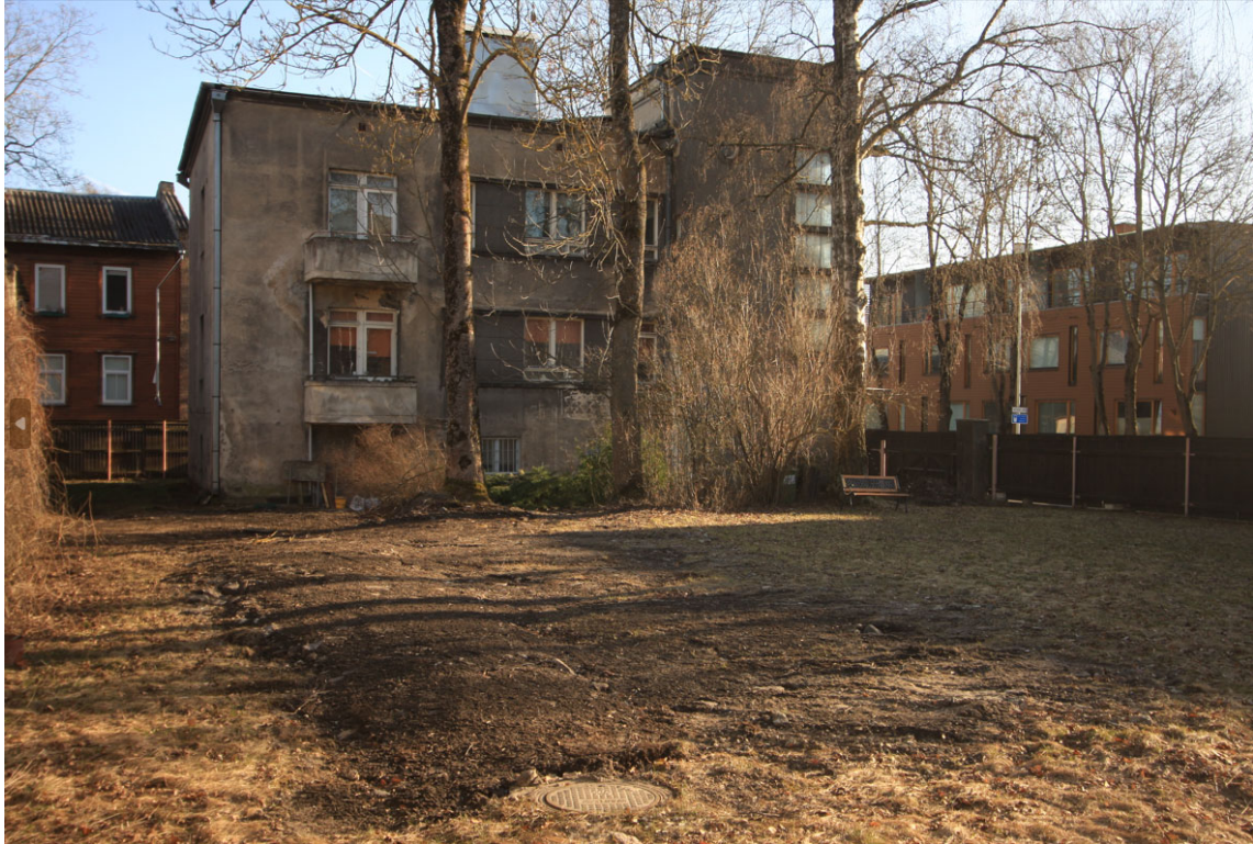
Hoone põhjaküljel paiknev hooviala. Puuderivi tähistab varasemat piiri elamu hoovi ja puuhoovi vahel
