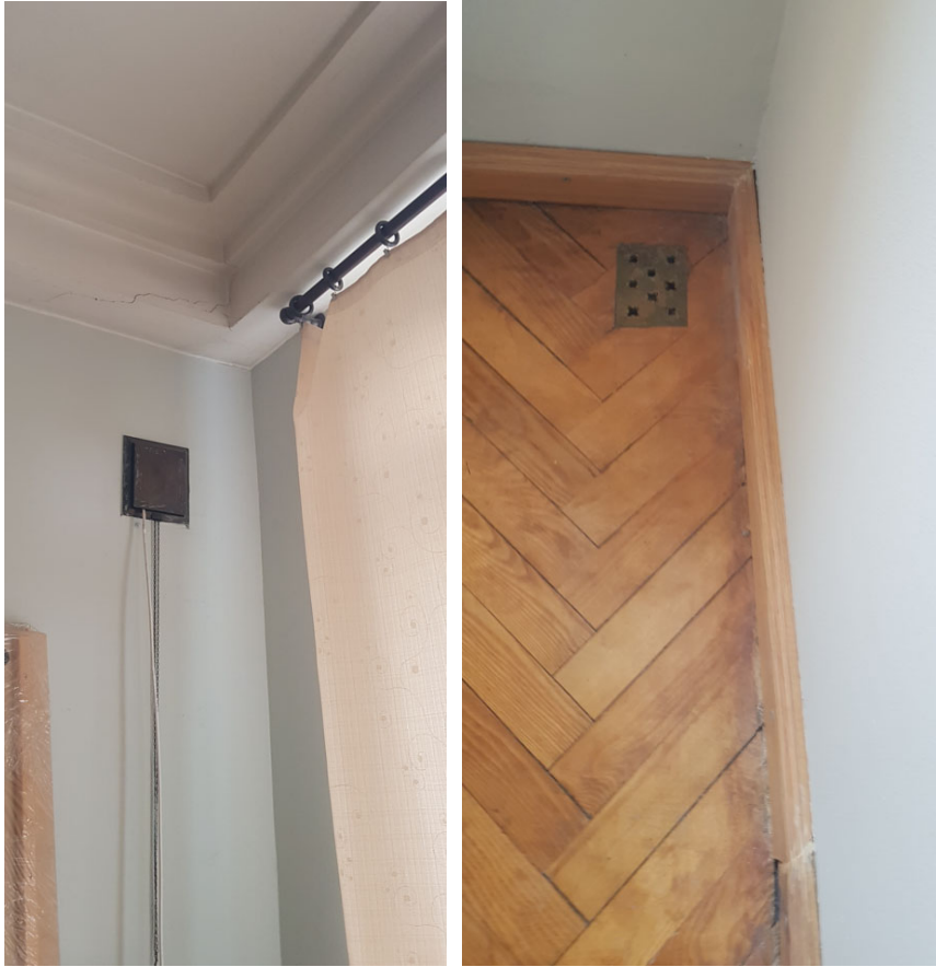
2. korruse korteri detailid, laekaniisid, ventilatsiooniava, tuulutav põrand ja parkett
