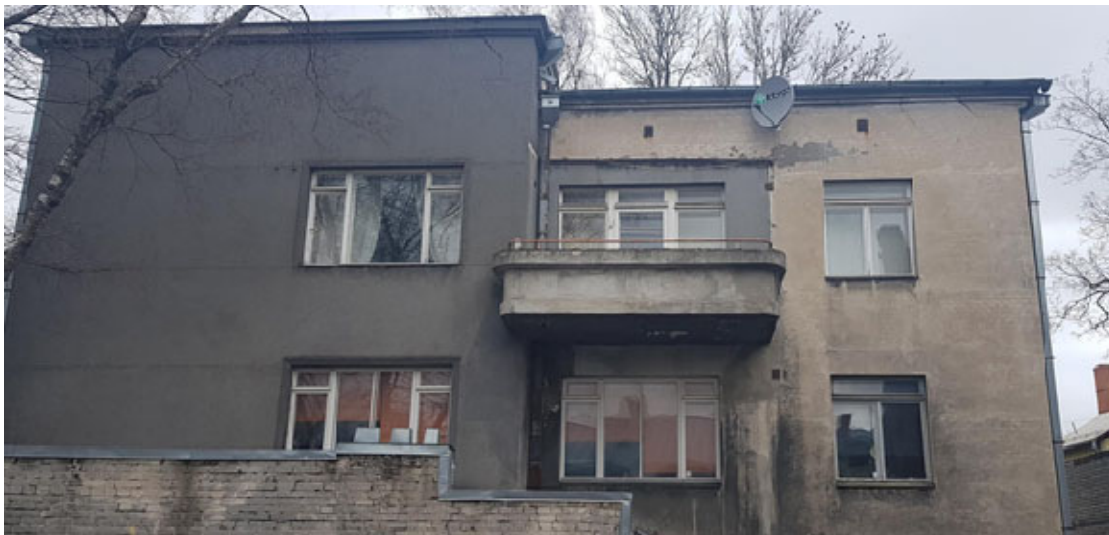
Hoone lõunakülje fassaad
