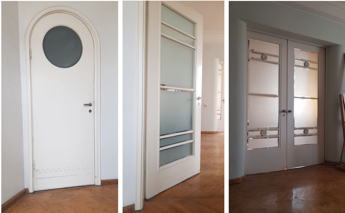
2. korruse korteri detailid, siseuksed. Teenijaruumide vaheuks ümara faasklaasiga aknaga, klaasi pind on liivapritsiga matistatud; samuti faasitud ja matistatud klaastahveluks ning ümarvormiga vaheseinad ja seinad sisse parkivad lükanduksed
