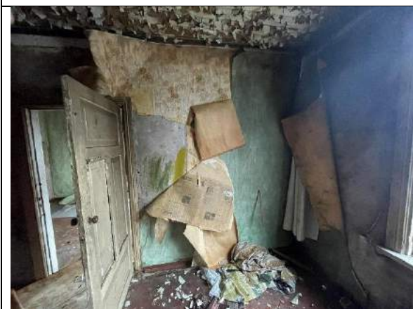
Foto 43. Tapeedikihid eluruumi seinal.
