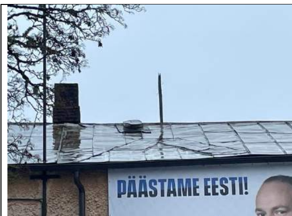
Foto 31. Vaade katusele ja katuseluugile.
