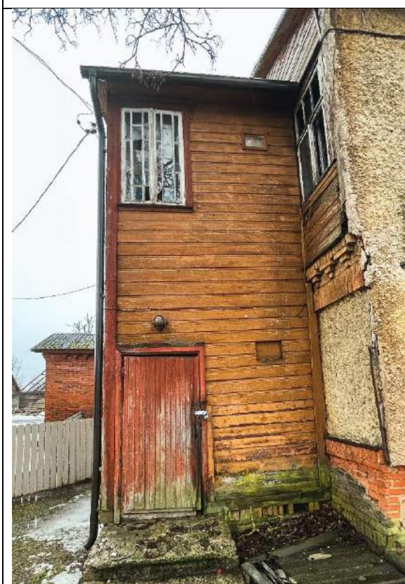
Foto 25. Puitkonstruktsioonis trepikoda.
