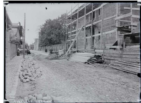
Foto vasakus servas näha Jakobsoni 33 peahoone ehitust katusekonstruktsioonide loomise ajast
