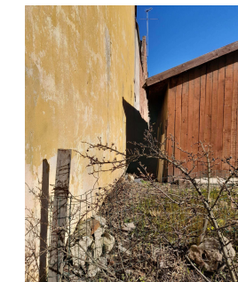
Fotol näha naaberkinnistu kuur, mille vihmavesi voolab vastu 33a tulemüüri seina
