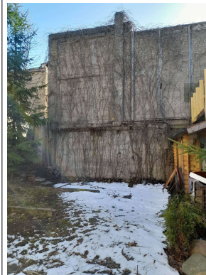
33a tänaseks lammutatud kahekorruseliste kuuride tugisein; puittalastik on kivimüüri sisse projekteeritud; hiljem on müürimaht kaetud tsementkrohviga
