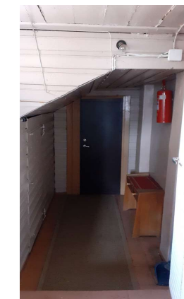
II korruse korterite külm esik; fotol seinte ja põrandate algupärane kattelaudis. Uksel sepishinged, esiplaanil laes sisse tapitud pööningu luuk
