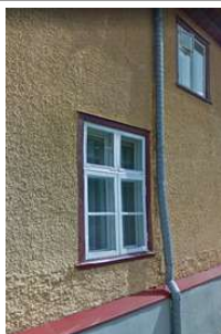
Elamu Pikk tänav 19 (autori foto 2023) võimalik eeskuju- aknapalede eeldatav ajalooline lahendus Jakobsoni 33 peahoone hoovipoolsel küljel.
