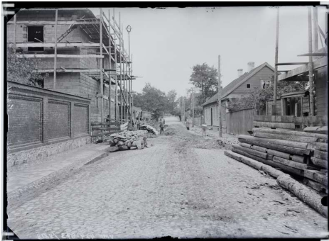
Foto paremas servas näha esimese korruse jagu laotud Jakobsoni 33 peahoone rõhtpalk seinaga ehitusmaterjali ning hoone tagastamisdokumentides kirjeldatud plankmaterjalist hoovi värvavat.
