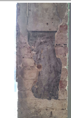
I-l korrusel kaupluse akna/ukse seina krohvi viimistlus; allosas rohekates/sinakates toonides kontrastse bordüürijoonega lahendus.
