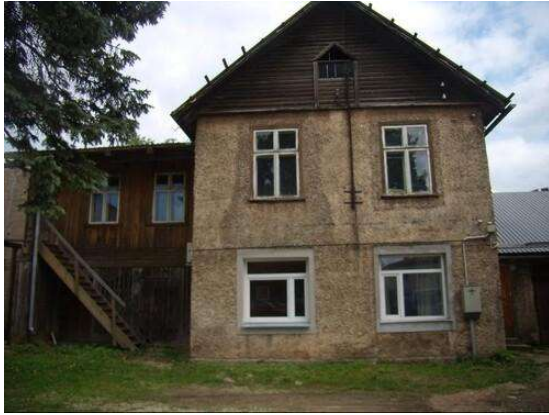
Fotol näha algupärane värvimata naturaalne pritskrohvi toon. Praeguseks on kaduma läinud pööningukorruse otsa-akna lahendus ja ülemiste korruste ilmselt algupärased aknad. Alumise korruse nelja kitsa akna asemele on tekkinud 2 suurt akent
