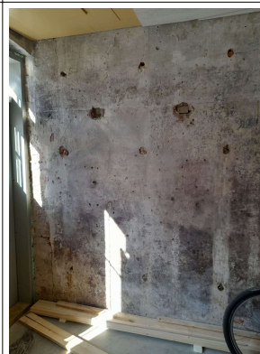
I-l korrusel kaupluseruumi algne lubikrohvist seinaviimistlus; alaosas roosakad toonid. Fotol näha algsed puittüüblid müüris kaupluse sisustuse kandmiseks.
