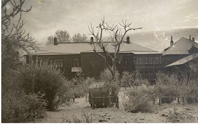
Talvine vaade hoone hoovipoolsele fassaadile. Foto põhjal võib väita, et esjalgu ehitati hoonele ainult üks puidust tagaveranda. Jakobsoni 33a-poolne väiksem puitveranda lisati hiljem.
