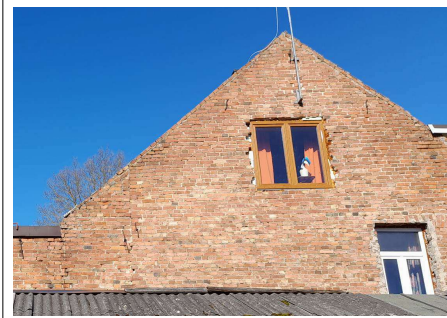
Fotol näha 33a vanema ja uuema hooneosa-vahelist müüriõmblusjoont ja isetekkelisi aknaid.
