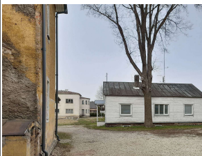
33b hoone on kaotanud tänaseks oma ajaloolise välisilme, kuid on säilitanud algse mahu: näha on ka algset maakivist soklit
