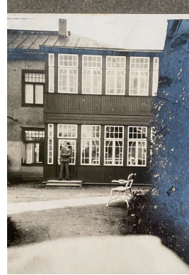
Suvine vaade hoone hoovipoolsele fassaadile; suurelt praeguseks lammutatud puidust veranda maht.
