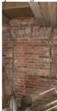
Kuurist kaupluse tahuurumi viiv kinnimüüritud ukseava
