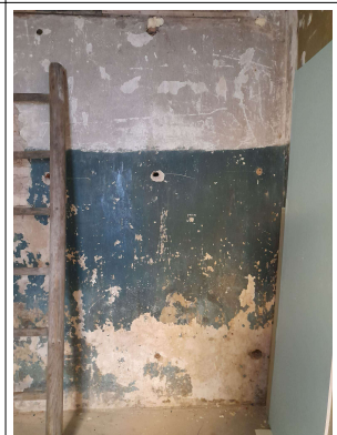
I-l korrusel kaupluse tagaruumi seinaviimistlus; lubikrohvil; tulmeroheline lubivärv seina alumisel osal.
