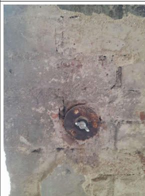
I-l korrusel kaupluse väliste ukse/akna- luukide lukustuse müürisisene hülss (hülssis tänapäevane liblikmutter).
