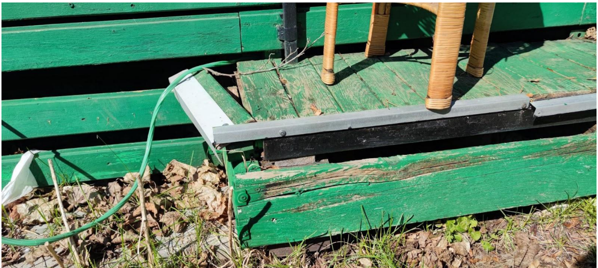
Pilt 15. Niiskuse ja päikese mõjul kahjustunud terrassile viiv trepp. Autori foto. 2023.
