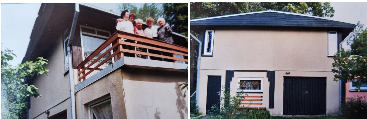
Karniis sirge esipaneeliga varem ja kolmnurkse esipaneeliga nüüd.
