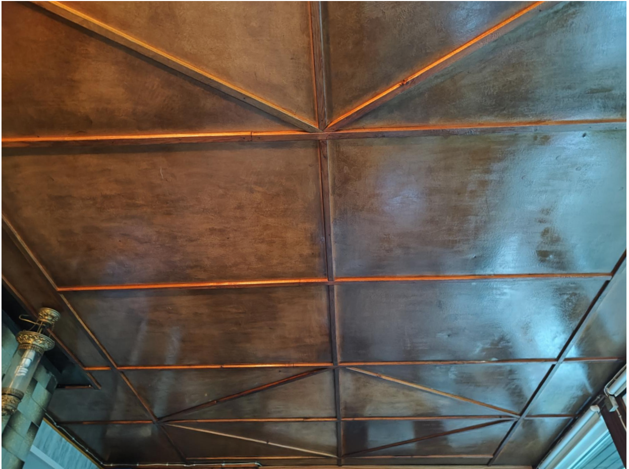
Pilt 33. Elutuba. Papist laepaneelid puidust liistudega. Autori foto. 2023.
