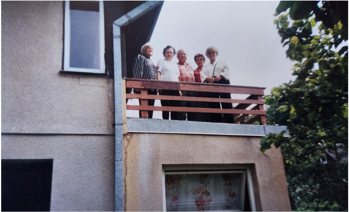
Pilt 19. Lääne fassaad. Niiskuskahjustused. Foto autori perekonna arhiivist. 2003.
