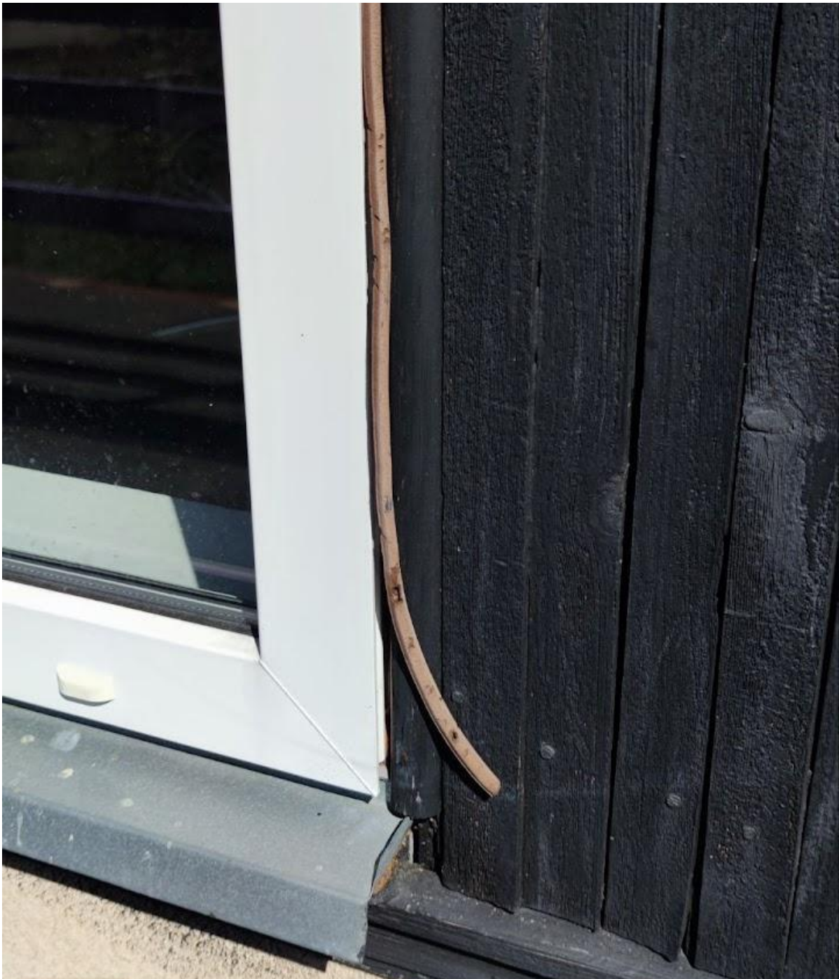
Pilt 21. Lõuna fassaad. Lahtitulnud akna tihenduskuum. Autori foto. 2023.
