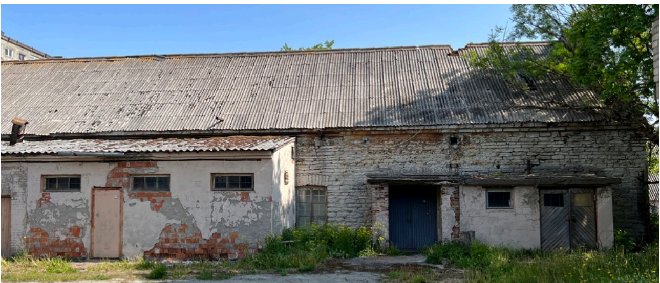
Pilt 34. Vaade tööstushoonele aia poolt, kust on näha erinevate ajastute seinasid ja nende erinevaid akna/ukse stiile. (Allikas: Autor)
