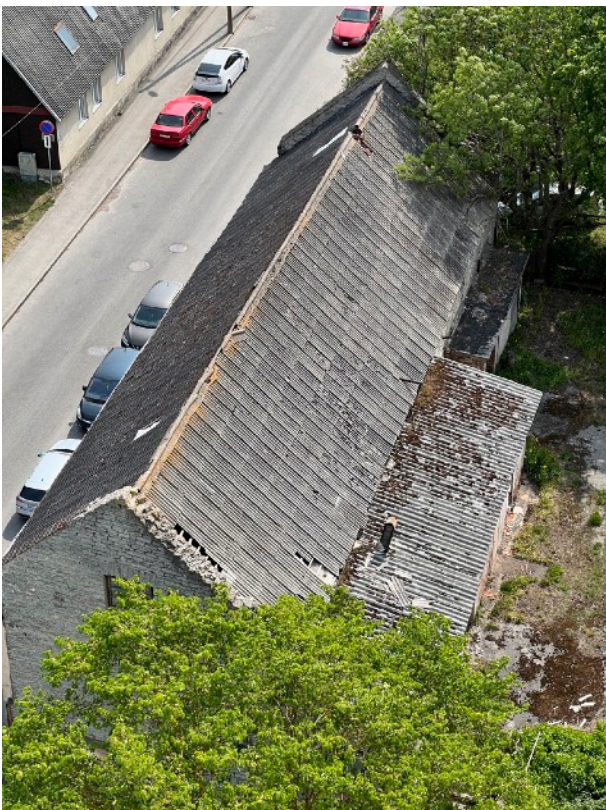
Pilt 26. Tööstushoone katuse pealtvaade. Näha auke ja sammalt katusel. (Allikas: Autor)
