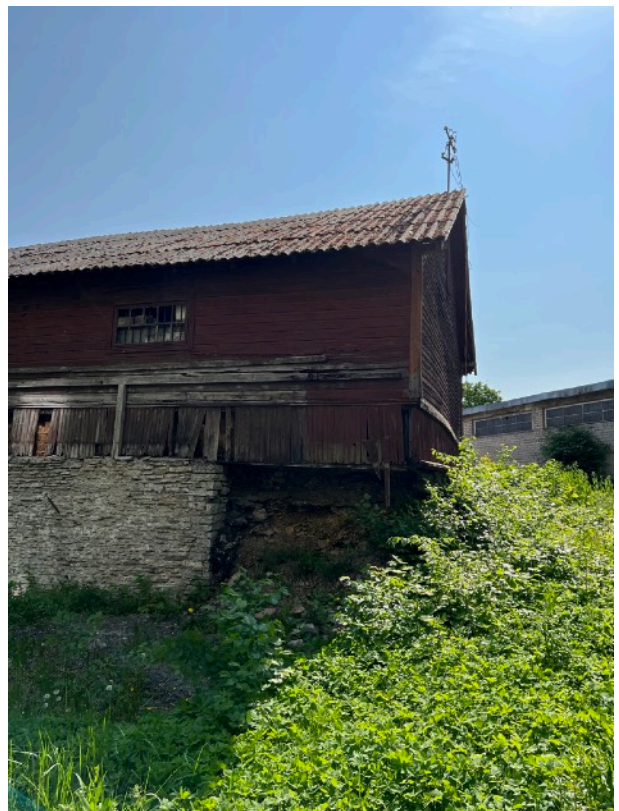
Pilt 10. Puumaja Lasnamäe tn. poolne kül, kus on näha, kuidas vundament on hoone ühe osa alt ära vajunud mööda müüritise külge, paljastades paekivist täite/pinnase kogu hoone all. (Allikas: Autor)
