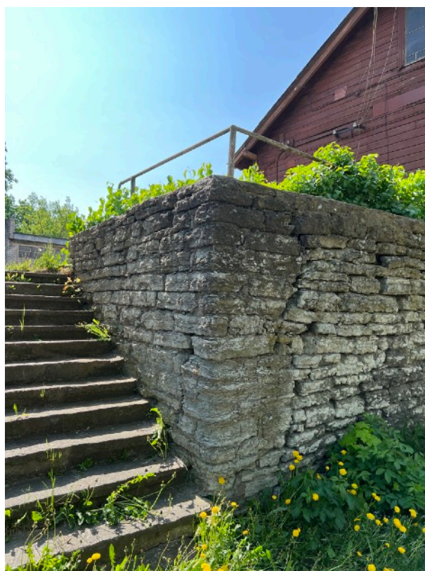
Pilt 31. Majadevaheline trepp. Näha kuidas trepp asub paekivist vundamendi sees, ühendades erinevaid maapinna kõrguseid. (Allikas: Autor)
