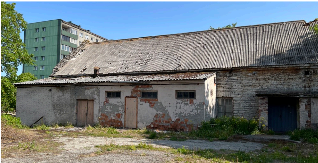
Pilt 20. Vaade tööstushoonele aia poolt, kust näeb nii algset seina (paekivist), kui esimest juurdeehitust (punased tellised ja seda kattev valge krohv), kui ka teist juurdeehitust (silikaattellisest ehitatud juurdeehituse laiendus Lasnamäe tn poole). (Allikas: Autor)
