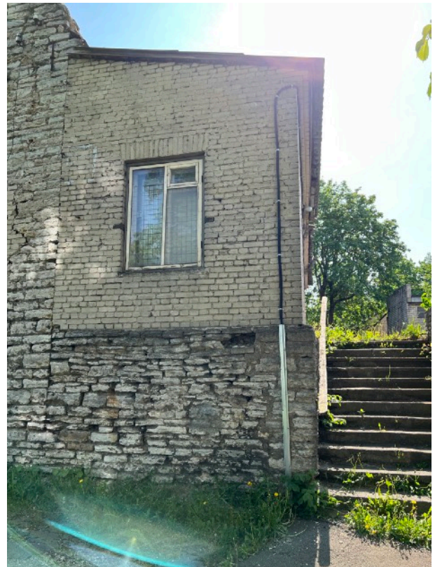
Pilt 24. Tööstushoone juurdeehituse Lasnamäe tn poolne külg, näha, kuidas kaks eksponeeritud fassaadikatet ei lähe üksteisega kokku ja loovad seeläbi keerulised liitumiskohad. (Allikas: Autor)
