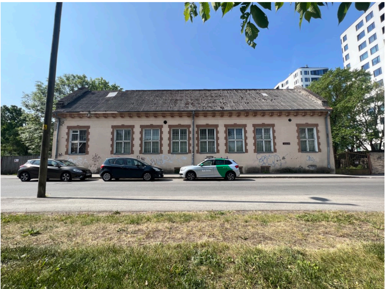
Pilt 8. Vaade Kivimuru tn 4 hoonele tänava poolt (kirdest). (Allikas: Autor)
