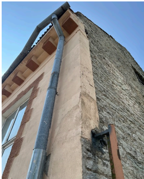
Pilt 38. Tööstushoone tänavapoolne sein ja karniis. Näha hambamotiivis karniisi katuse all ja kuidas see värvi ja stiili poolest loob akna "raamiga" terviku. Samuti näeb plekist vihmaveesüsteemi. (Allikas: Autor)
