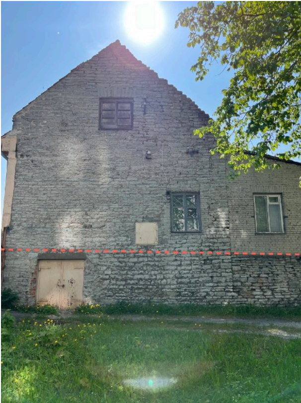
Pilt 11. Tööstushoone Kivimurru tn ääres, kus punase punktiirjoonega on näidatud, kust jookseb keldrikorruse piir. Näha ka kuidas algele hoonele hiljem juurde tehtud silikaattellisest lisand jookseb justkui juurde laotud seinapikenduse peal, sest kivid hakkavad maa ligidalt jooksmata teiste kividega ühes joones, kuid ei sobitu nendega liitesse kokku. (Allikas: Autor)
