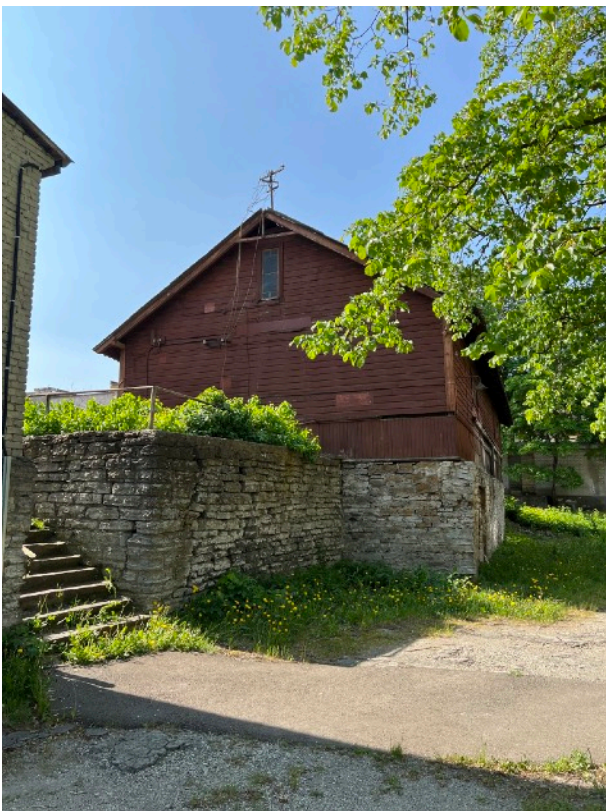
Pilt 9. Puumaja tänavapoolne kül, näitamaks kuidas paekivist vundament jätkub hoone alt krundi kõrgendiku toetavaks seinaks. (Allikas: Autor)
