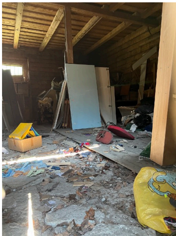
Pilt 29. Puumaja sisemus. On näha, et põrand on tehtud laiast puitliistudest, mis asetsevad otse paekivist pinnasele. Seisukord on halb - vaid osal põrandast on veel puitlaudis alles. (Allikas: Autor)
