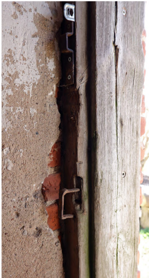
Joonised 38-40. Välisuste sepsidetailid. Autori fotod.
