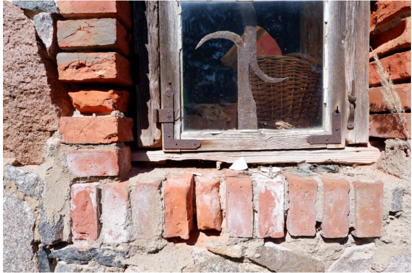
Joonis 51. Sepistatud trell panipaiga akna seespool. Autori foto.
