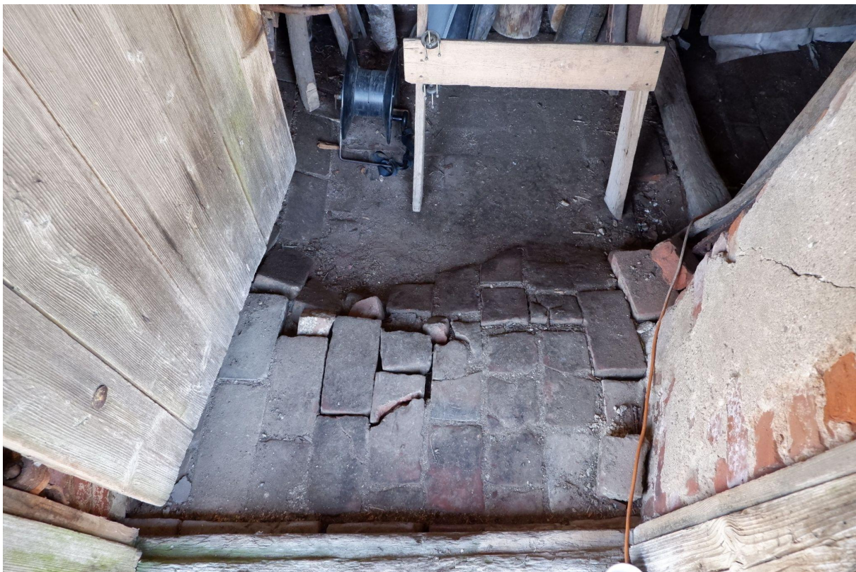
Joonis 10. Tellispõrand tagumise välisukse juures, väga suur vajum. Autori foto.
