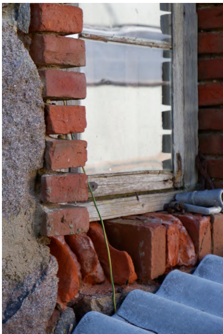
Vasakul. Joonis 18. Väljuhutud segu ja kahjustunud tellised hoone otsaseinas. Autori foto.
