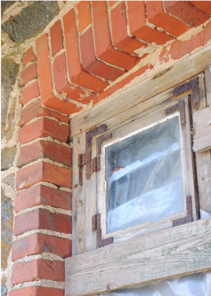
Joonis 49. Tuulutusakend (fortuška). Sepistatud roostetavad nurgikud, nurkhinged ja lehthinged. Autori foto.
