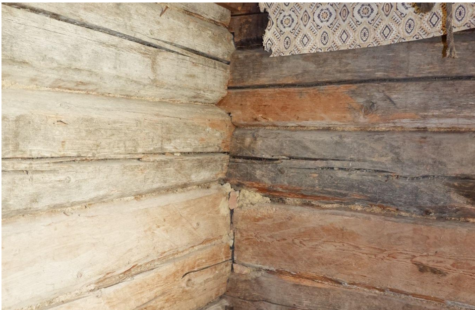
Joonis 20. Palkidest siseseinad. Autori foto.
