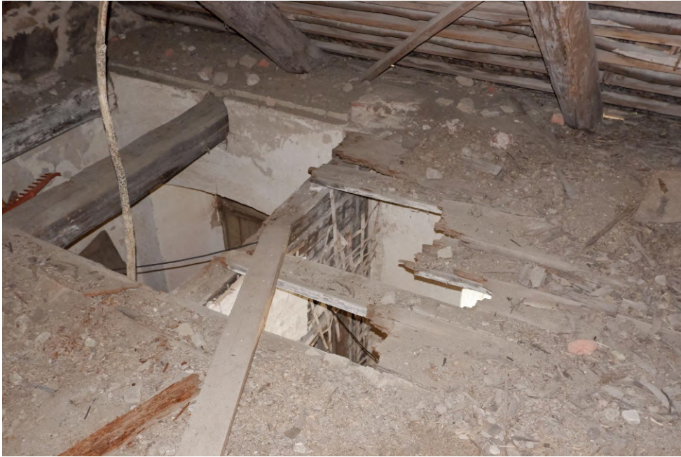
Joonis 27. Pehkinud ja alla kukkunud laudis. Autori foto.
