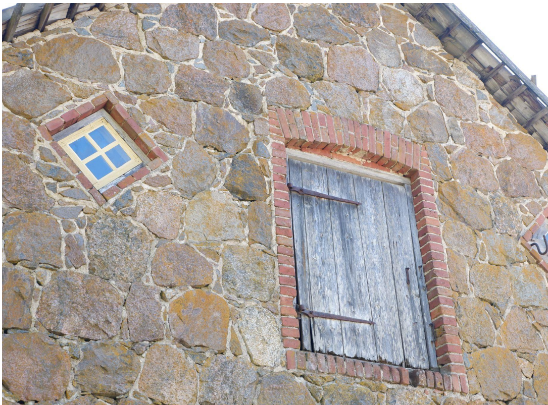
Joonis 44. Otsaseintes katusekorrusel asuvad sepistatud latthingedega ukсед. Autori foto.
