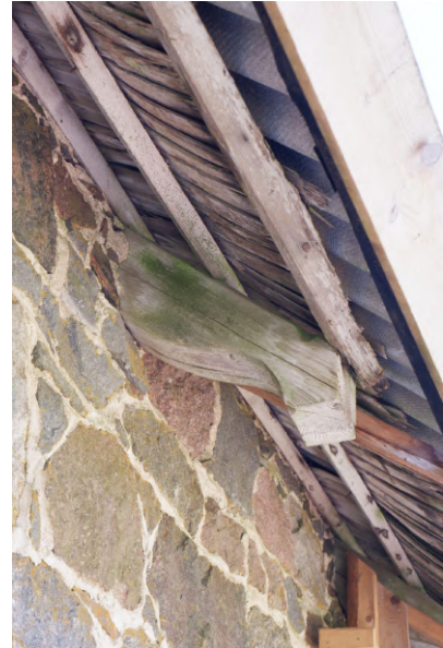
Paremal. Joonis 33. Profileeritud sarikaots. Autori foto.
