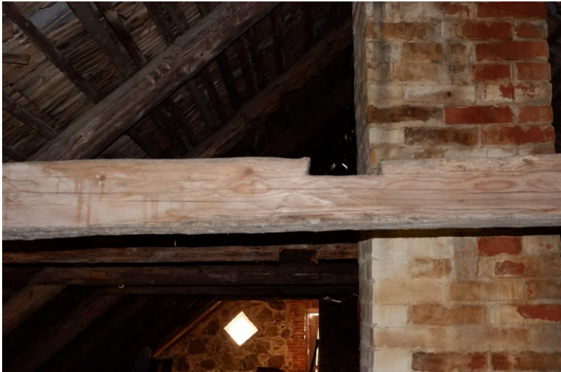
Joonis 29. Pennidel on näha ebakorrapäraseid väljalõikeid. Autori foto.
