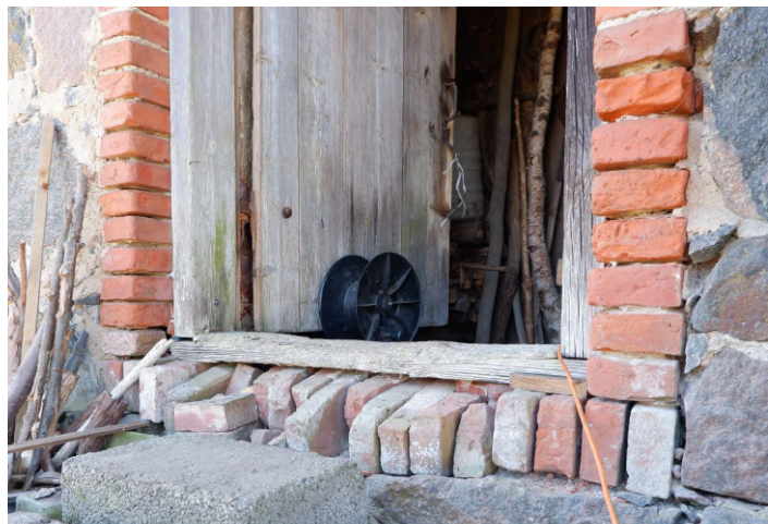
Vasakul. Joonis 18. Väljuhutud segu ja kahjustunud tellised hoone otsaseinas. Autori foto.
