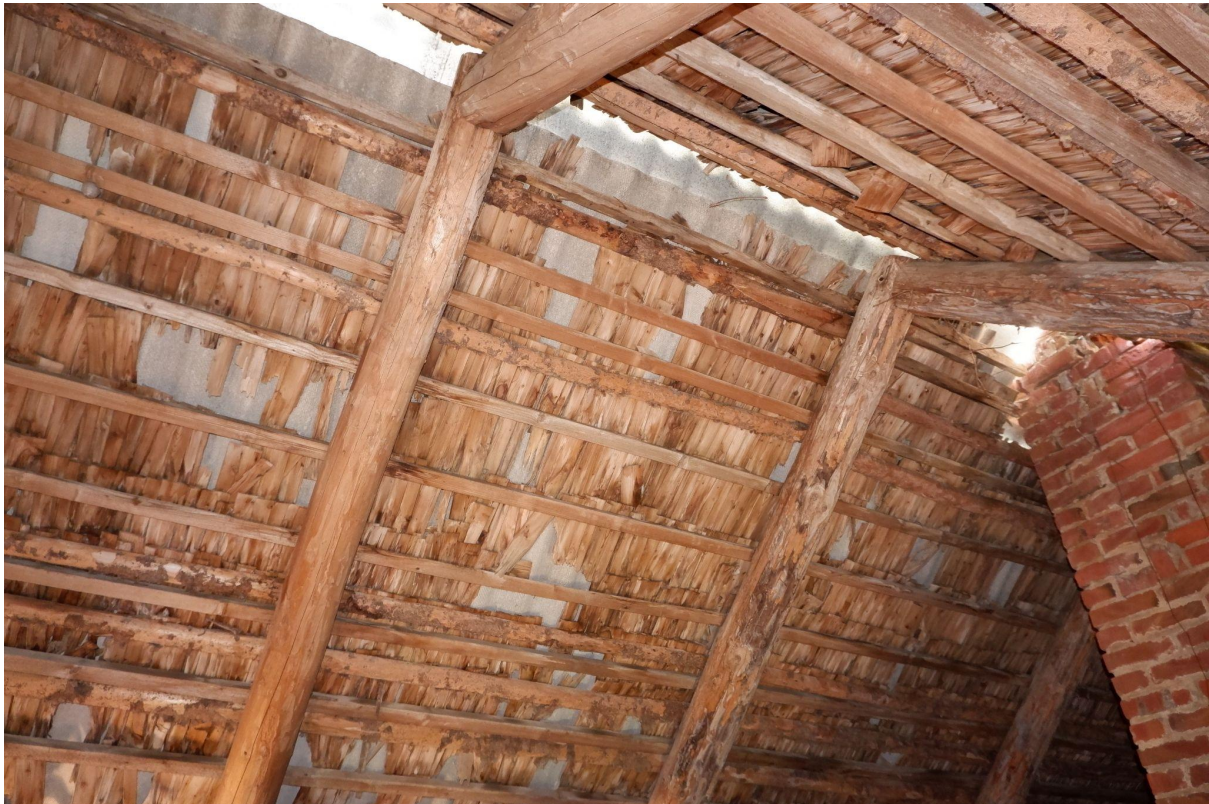
Joonis 30. Nõukogudeaegne eterniit vana laastukatuse peal. Autori foto.
