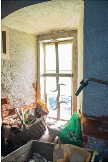
Joonis 51. Sepistatud trell panipaiga akna seespool. Autori foto.
