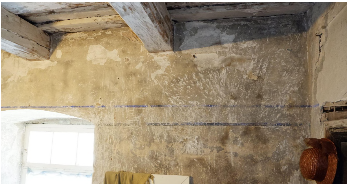
Joonis 22. Suur pragu siseseina lubikrohvi viimistluses. Autori foto.
