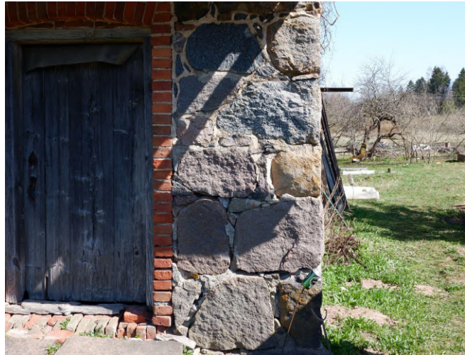
Vasakul. Joonis 12. Hoone põhjapoolne klombitud maakividest nurk. Autori foto.
