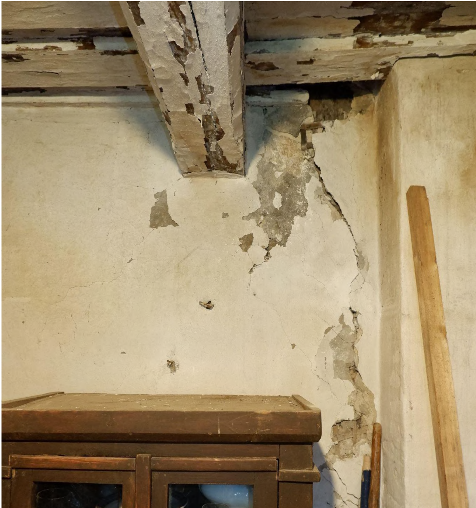
Joonis 22. Suur pragu siseseina lubikrohvi viimistluses. Autori foto.
