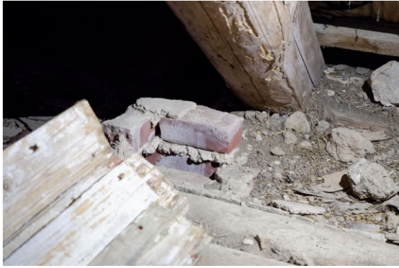
Joonis 15. Välisseina tuulutusaava katusekorrusel. Need asuvad umbes iga kolme sarika tagant. Autori foto.
