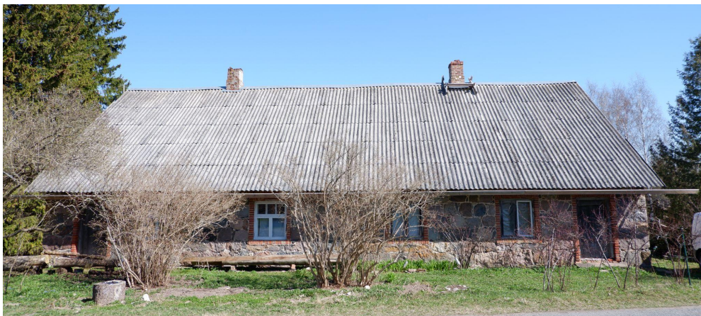
Joonis 46. Hoone esifassaadil on aknad asendatud erinevate akendega, millel pole esialgset klaasijaotust jälgitud. Autori foto.
