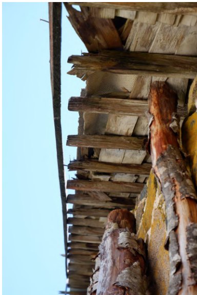
Vasakul Joonis 32. Pehkinud roovituse otsad.
