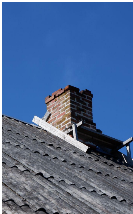
Vasakul. Joonis 34. Algupärane korstnapits. Autori foto.
