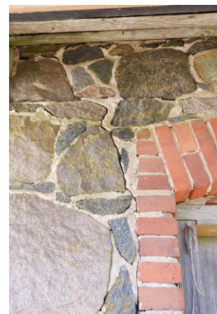
Joonis 8. Pragu hoone läänenurgas. Autori foto.
