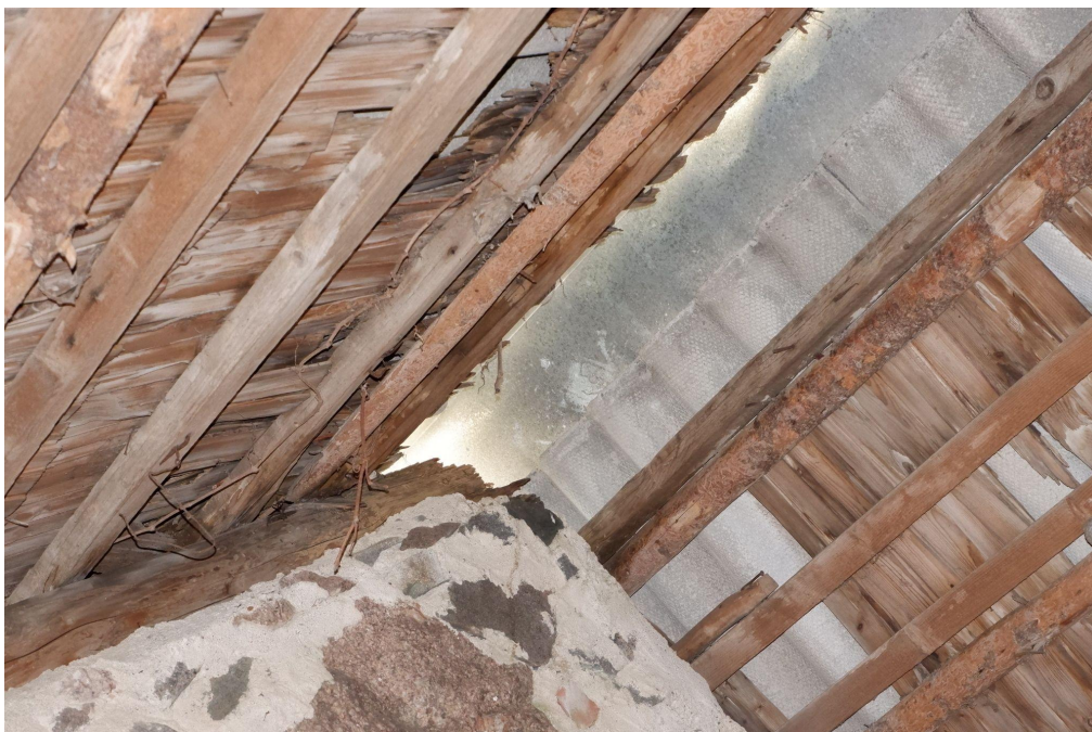
Joonis 31. Otsaviilu müürlatt on pehkinud. Autori foto.
