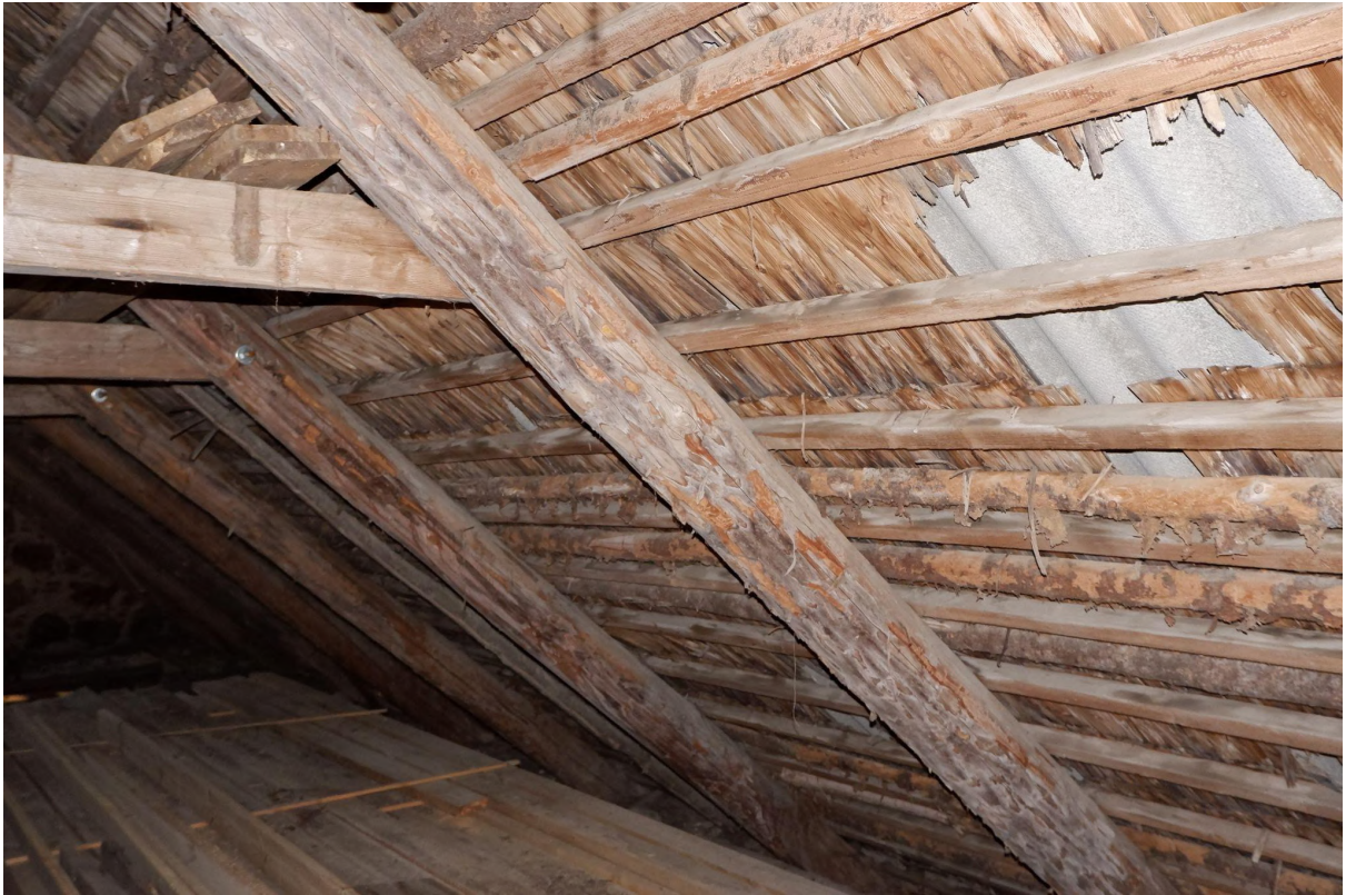
Joonis 28. Sarikas, roovid, vana laastukatus. Sarika ja penni liitekohas näha raudpoldiga tugevdamist.. Autori foto.
