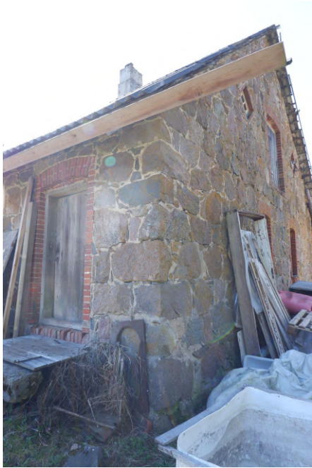
Vasakul. Joonis 12. Hoone põhjapoolne klombitud maakividest nurk. Autori foto.
