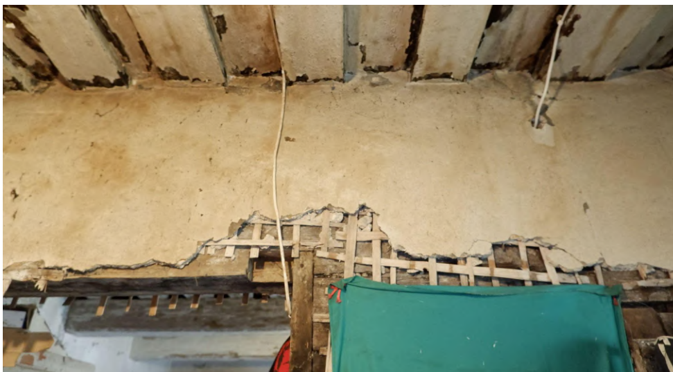
Joonis 21. Maha varisev krohv siseseinal. Autori foto.
