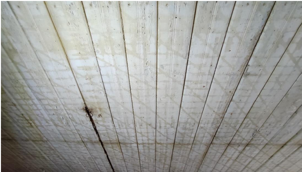
61. Esimesel korrusel säilinud mõnes toas ehitusaegsed laelauad (autori foto)
