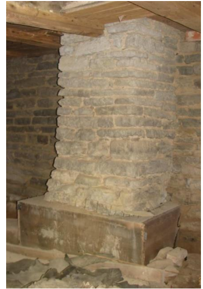
40. Korstna vundament nr 2 (autori foto)
