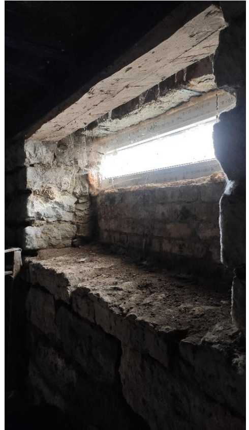
20. Pooles ulatuses kinni laotud topeltsillustega keldriaken (autori foto)
