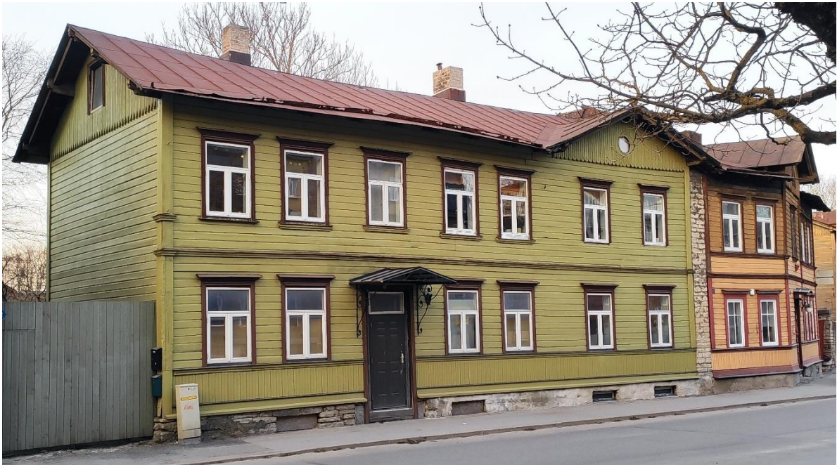
53. Vaade hoone katusele Tööstuse tänavalt 2023 (autori foto)
