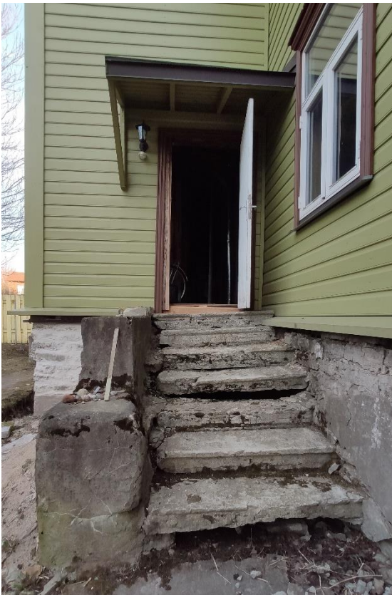
47. Hoovitrepikoja amortiseerunud astmeplaadid (autori foto)
