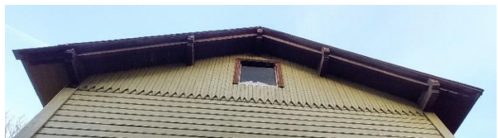
54. Otsaseina hästi säilinud pärlinkite pikendused (autori foto)
