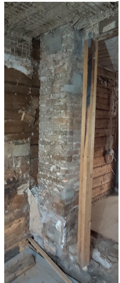
43. Korstnajalg esimesel korrusel (autori foto)
