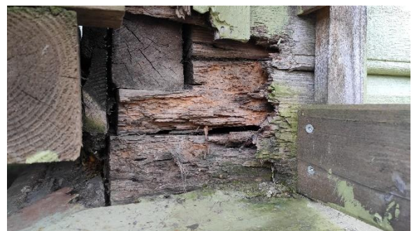
23. Voodrilaua alt paljanduv pehkinud palk (autori foto)
