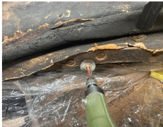
34. Detailide puhastamine Dremeliga.
