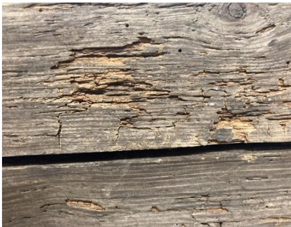
15. Alumise plaadi pehkinud puit.
