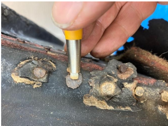
33. Väikeste metalldetailide puhastamine klaasfiiberpliatsiga.
