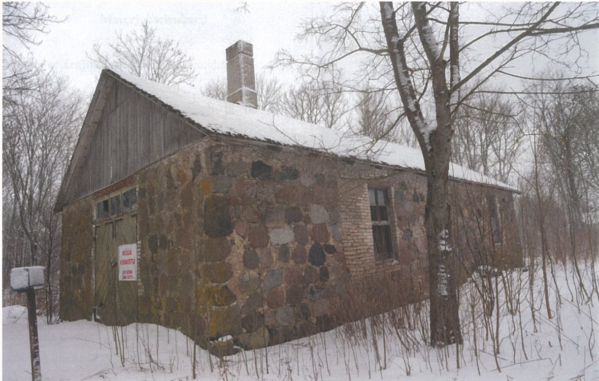
1. Hoone välisilme, vaade kirdest 08.02.2015
