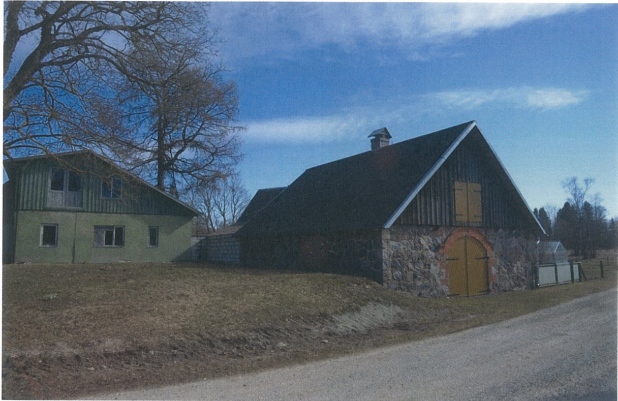
1. Hoone esifassaad, vaade loodest 29.03.2014
