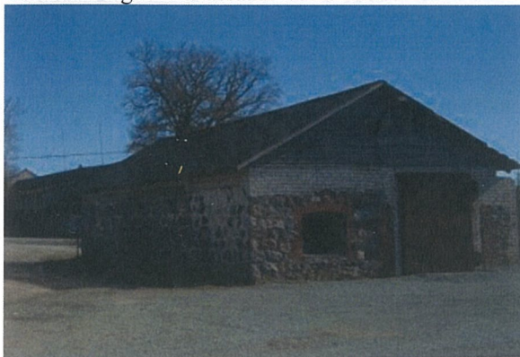
5.Garaazi tagumine fassaad 29.03.2014
