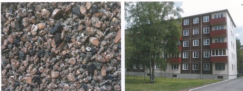
7. Värvilise inertainega dekoratiivbetoon Karjamaal Tööstuse tänaval. Foto 2010
