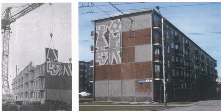
12. Akadeemia tee 6 seinapanoo paigaldamine. Must-valge foto: S. Rosenfeld, 1962. EFA 0-90209
