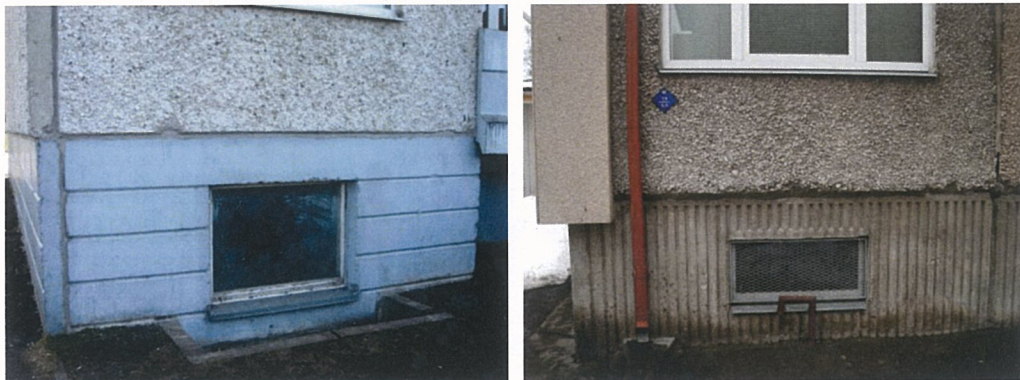
10. Akadeemia tee 7a ja rõhtvagudega ja Sõpruse pst. 198 püstvagudea soklipaneelid. Foto 2010
