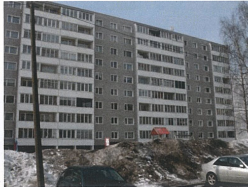
18. Tervenisti soojustatud hooned. Viimistlemisel on kasutatud krohvi ja kivivoodrit. Foto 2010
