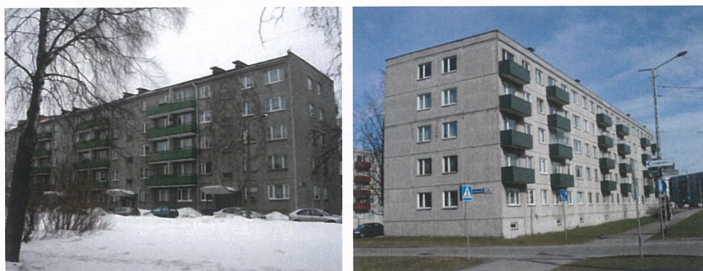
14. E. Vilde tee 59 ja Mustamäe tee 26 soojustamata hooned. Esimesel fotol on puitrõdud, teisel profileeritud plekist. Foto 2010
