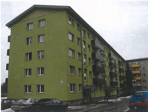
18. Tervenisti soojustatud hooned. Viimistlemisel on kasutatud krohvi ja kivivoodrit. Foto 2010
