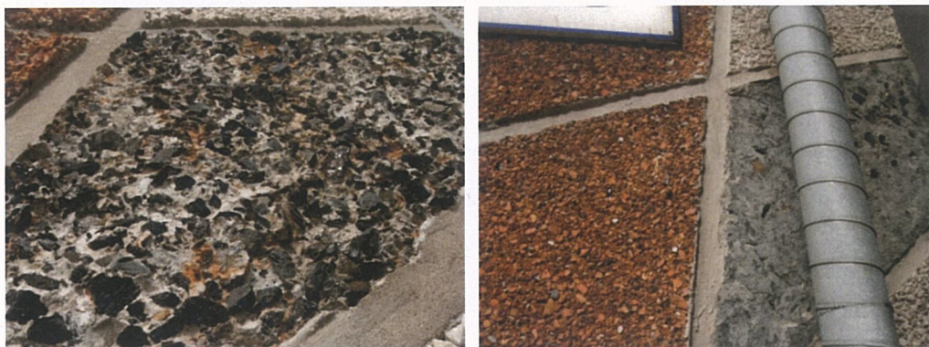
13. Akadeemia 68 otsaseinapaneelide viimistlusmaterjalid: must šlakk ja punane telliskivipuru. Paremal pildil on näha, kuidas suurem osa šlakiga kaetud pinnast on hävinenud. Foto 2010
