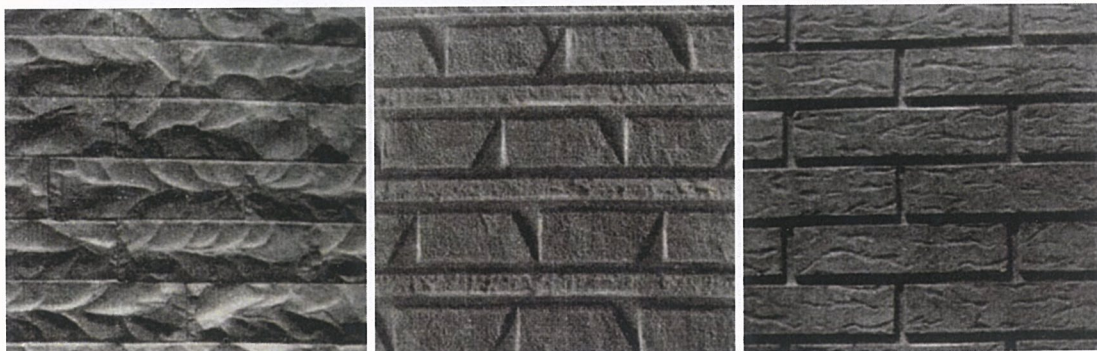
8. Plastmassmatriitside abil tehtud pinnafaktuuri näited. Artiklis oli toodud näiteid Soomest. Repro: T. Kaur 1978. Ehitiste viimistlus Soomes. – Ehitus ja Arhitektuur nr 1, lk 28.
