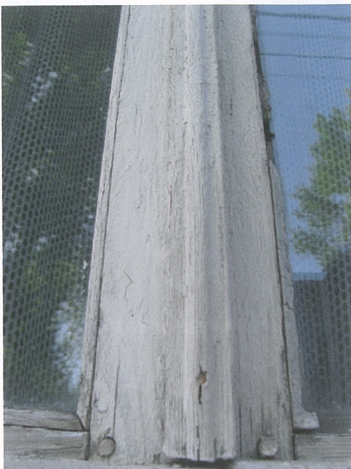
Rohu 24 akna murenev ja lagunev kitt
