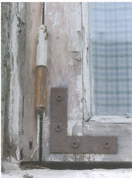
Õle 43aken hingega, aknanurgikuga ja puitliistuga
