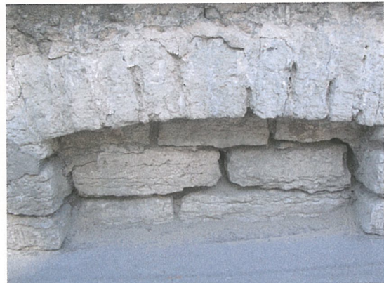
Rohu 20 keldriakna asukoht
