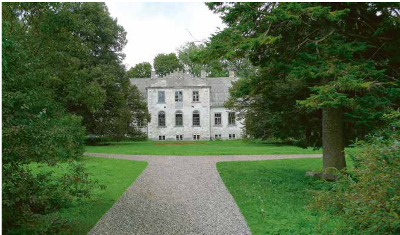
65. Lööne mõisa esiväljak. Üleval olukord 2011. aasta suvel ning all sama vaade fotomontaažil restaureerituna. Lööne esiväljakut ümbritsev ringtee on amortiseerunud ja tuleks uuesti rajada. Praegune teekatend on murukamaraga kohati läbi kasvanud ja ilma selgete piirideta. Esinduslike lillepeenarde rajamiseks on sobiv esiväljaku serv või keskaik.
